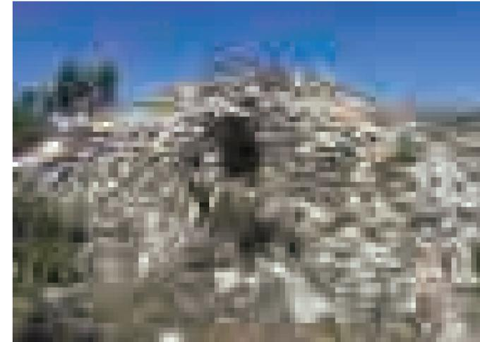
calizas previamente troceadas, hasta formar una bóveda exterior. En el centro quedaba el espacio necesario para instalar la leña que se prendería fuego para quemar la piedra. Por medio de un hueco en la base del horno, el calero iba avivando el fuego sin dejar que se apagase durante todo el proceso de cocción.
